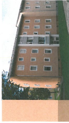
Schubertplatz, Leoben (erbaut zwischen 1900 und 1910) - Anwesen (Dachstuhl) - Eingang (Bauhaus)
